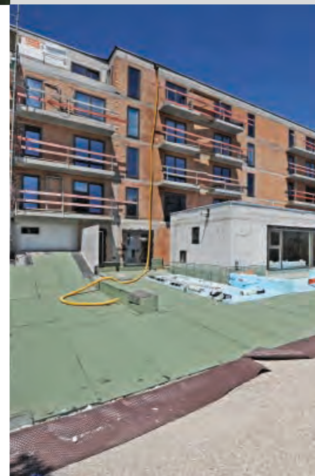
Der Rohbau des viergeschossigen Gebäudes steht (Juni 2007).
